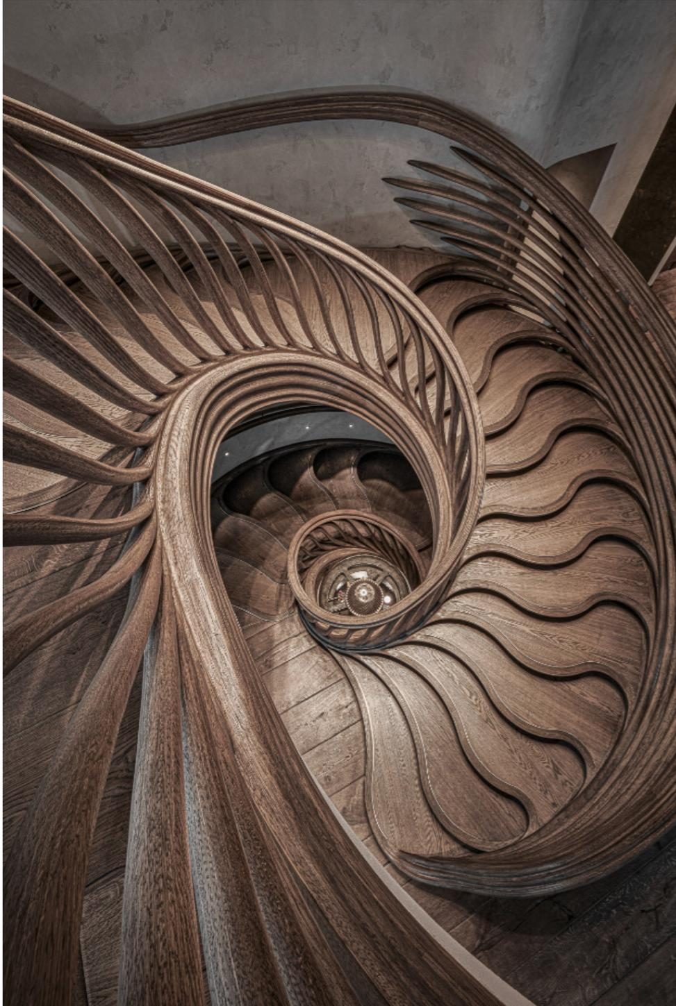
Die organische Treppe des Projektes, mit dem Namen "RS-110 Stairstalk" des Architektenbüros Atmos Studio, in Kooperation mit der Firma Markiewicz besteht aus einem stählernen Tragwerk, mit einer Ummantelung aus Holz. Ergänzt wird das Ganze durch ein handgeschnitztes Holzgeländer in Sonderanfertigung.
