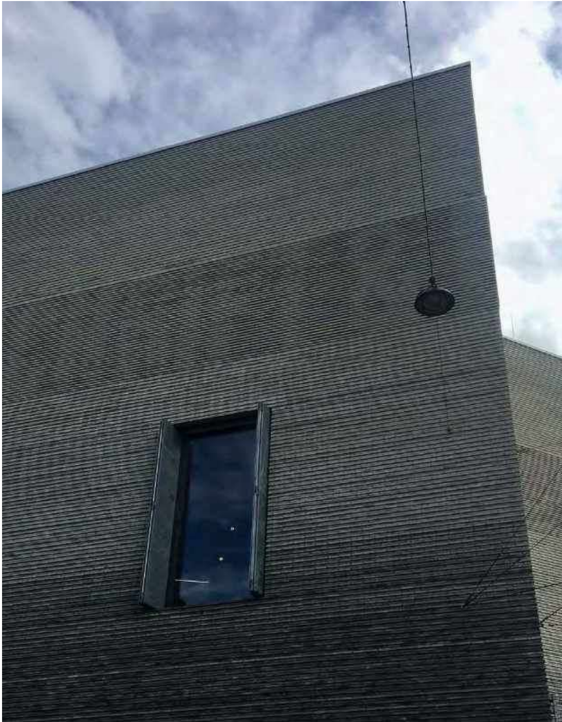
Erweiterungsbau Kunstmuseum, Christ & Gantenbein, Basel, 2015
